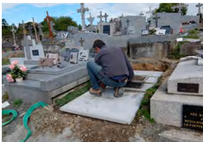
1 - L'entreprise de pompes funèbres, ou le marbrier, qui intervient sur une sépulture est responsable de l'élimination correcte des terres et eaux de caveaux. © P&C - Sandrine LARRAMENDY 2016
