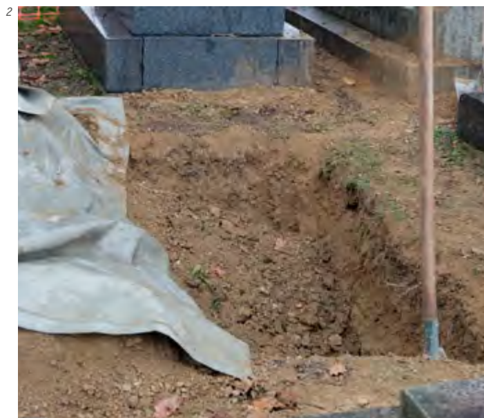
2 - Creusement en cours d'une fosse pleine terre par les agents municipaux fossoyeurs dans le cimetière de l'Est de Rennes (35). Ici, les fosses en pleine terre peuvent y atteindre la profondeur de 2,50 m (trois cercueils superposés). © P&C - Sandrine LARRAMENDY 2015
