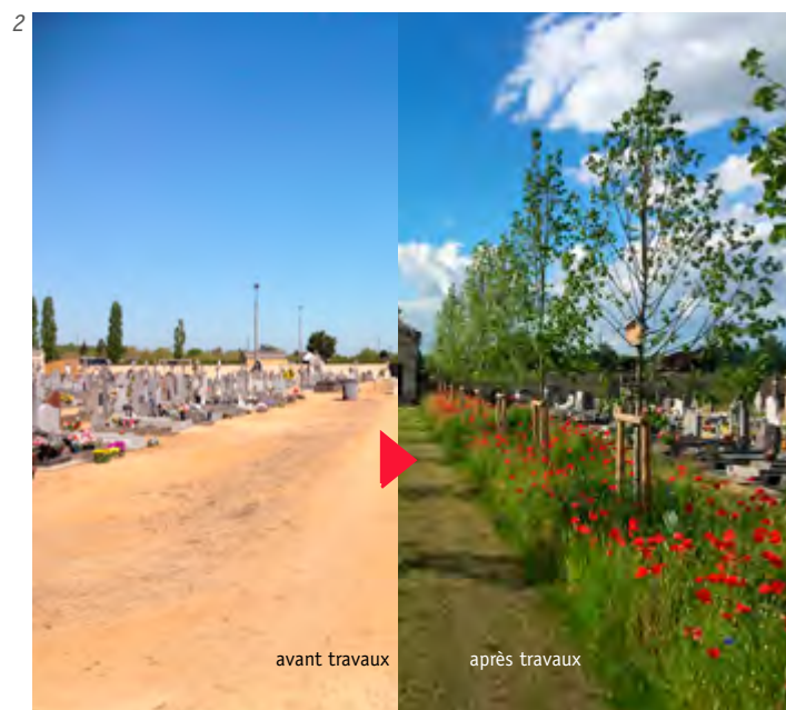
2 - Cimetière de Durtal (49) avant les travaux. 3 - Le même cimetière après travaux. Recours à un paysagiste concepteur (Agence Talpa de Saumur) pour résoudre un problème de stagnation d'eau en surface rendant les allées impraticables par temps de pluie (réalisation d'une noue, plantation de tilleuls) et améliorer le paysage du cimetière grâce aux plantations. © Agence Talpa - Arnaud DELACROIX
