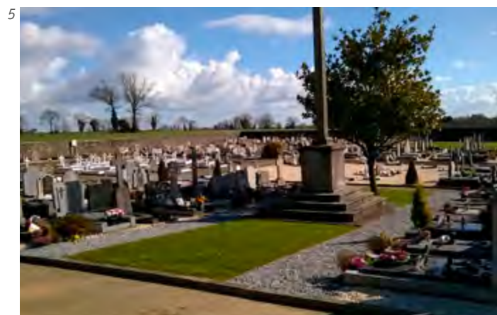
5 - Cimetière d'Ambrières-les-Vallées (53). Dans le cadre du passage au « zéro pesticides », une réfection a été menée : allées piétonnes refaites avec du gravier granit concassé en 10-12 mm et inter-tombes avec du gravier roulé-lavé de couleur clair (issu de la carrière locale de Montreuil Poulay). Pour éviter la pousse de plantes spontanées, un géotextile a été posé. © Emmanuel JAVAUX 2016
