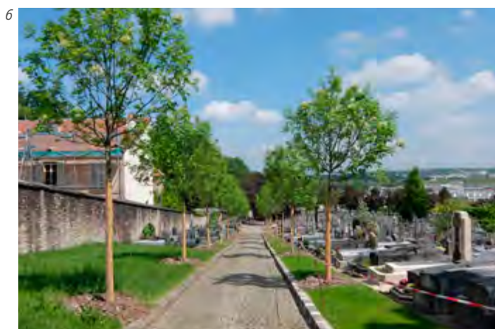
6 - Allée du cimetière des Gonards à Versailles (78) récemment réhabilitée : largeur réduite, remplacement de la surface en enrobé par des pavés de récupération, accotements enherbés, arbres plantés. La surface imperméable à désherber a été diminuée. © P&C - Sandrine LARRAMENDY 2016
