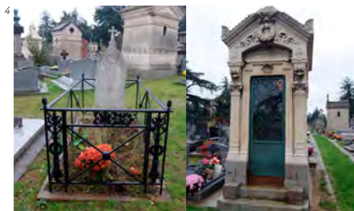
4 - Cimetière de l'Est à Angers (49). La grille de cette sépulture a été repeinte par les agents. 5 - Cette chapelle, jugée patrimoniale, a été récupérée par la Ville d'Angers à la suite d'une procédure de reprise de concession. Une étiquette avec les lettres VA (ville d'Angers) en bas à gauche indique que la ville est aujourd'hui propriétaire du monument. © P&C - Sandrine LARRAMENDY 2015
